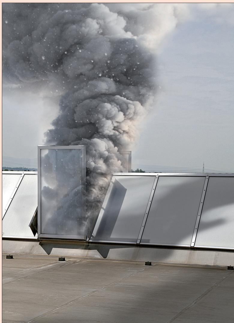
*Qualifizierte Rauchabzugsgeräte, hier in einem Satteldachlichtband eingebaut, führen im Brandfall gezielt die Rauch- und Brandgase aus dem Gebäude ins Freie ab*
